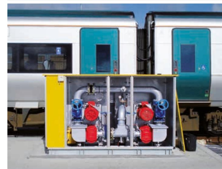
**Kompaktes Innenleben:** Pumptechnologie vom Marktführer sichert schnell und zuverlässig das Entsorgen von Abwässern aus Bordtoiletten.
